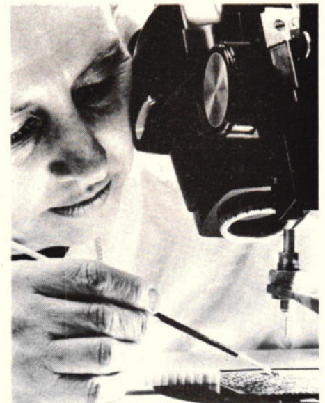
Op deze foto, genomen in de fabriek Honeywell in Phoenix, V.S., wordt een vloeimiddel aangebracht voordat de meer dan honderd IC's op het computeronderdeel worden gesoldeerd. De schakelingen zitten op een plaatje van zo'n 760 vierkante millimeter. Vroeger – bij oude modellen procescomputers – zouden schakelingen met dezelfde functies een flinke kamer hebben gevuld.
